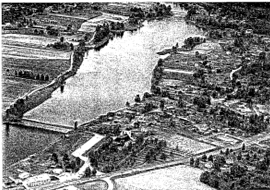
Dalarna, Sweden. Hängbron är belägen vid Floda kyrka. Bron är, med sina 158 meters spännvidd, den längsta iråhängbron i Sverige.
